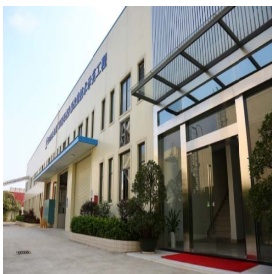
盐田污泥 RRS 水解碳化处理工程现场
